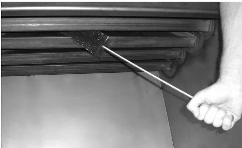
Nettoyez, à l'aide du goupillon (fourni) les 4 éléments inclinés du passage des fumées à l'intérieur de la chambre de combustion.
